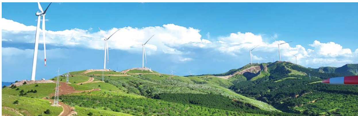
协鑫能科辽宁聚鑫 50MW 风电项目
