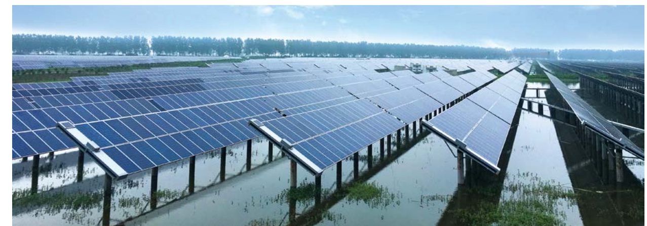
协鑫新能源智能运维机器人
