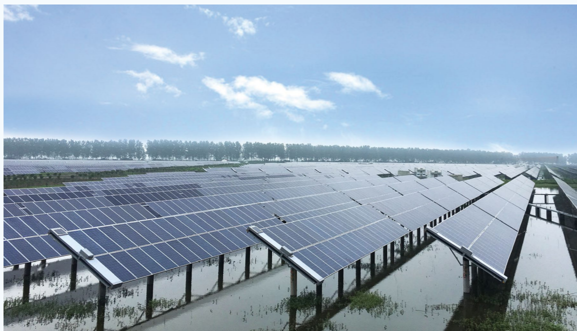
协鑫新能源智能清扫机器人助力智能化运维
