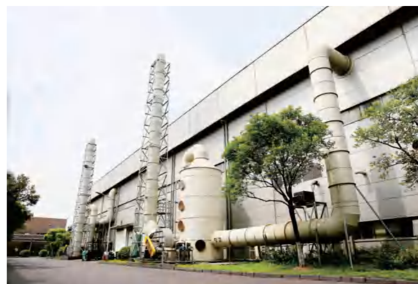
江苏协鑫硅材料科技发展有限公司新增加的切片水磨除尘系统
