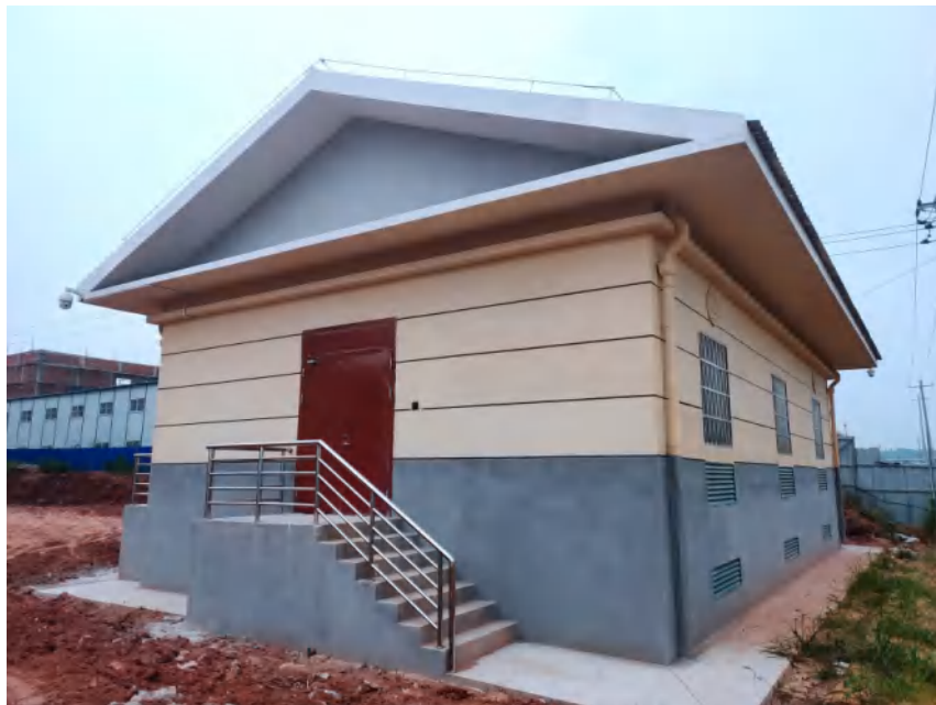
安徽金寨增量配电网
