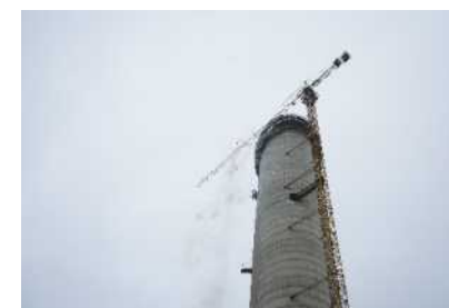
2019年12月,徐州第二生活垃圾焚烧发电项目烟囱结顶
