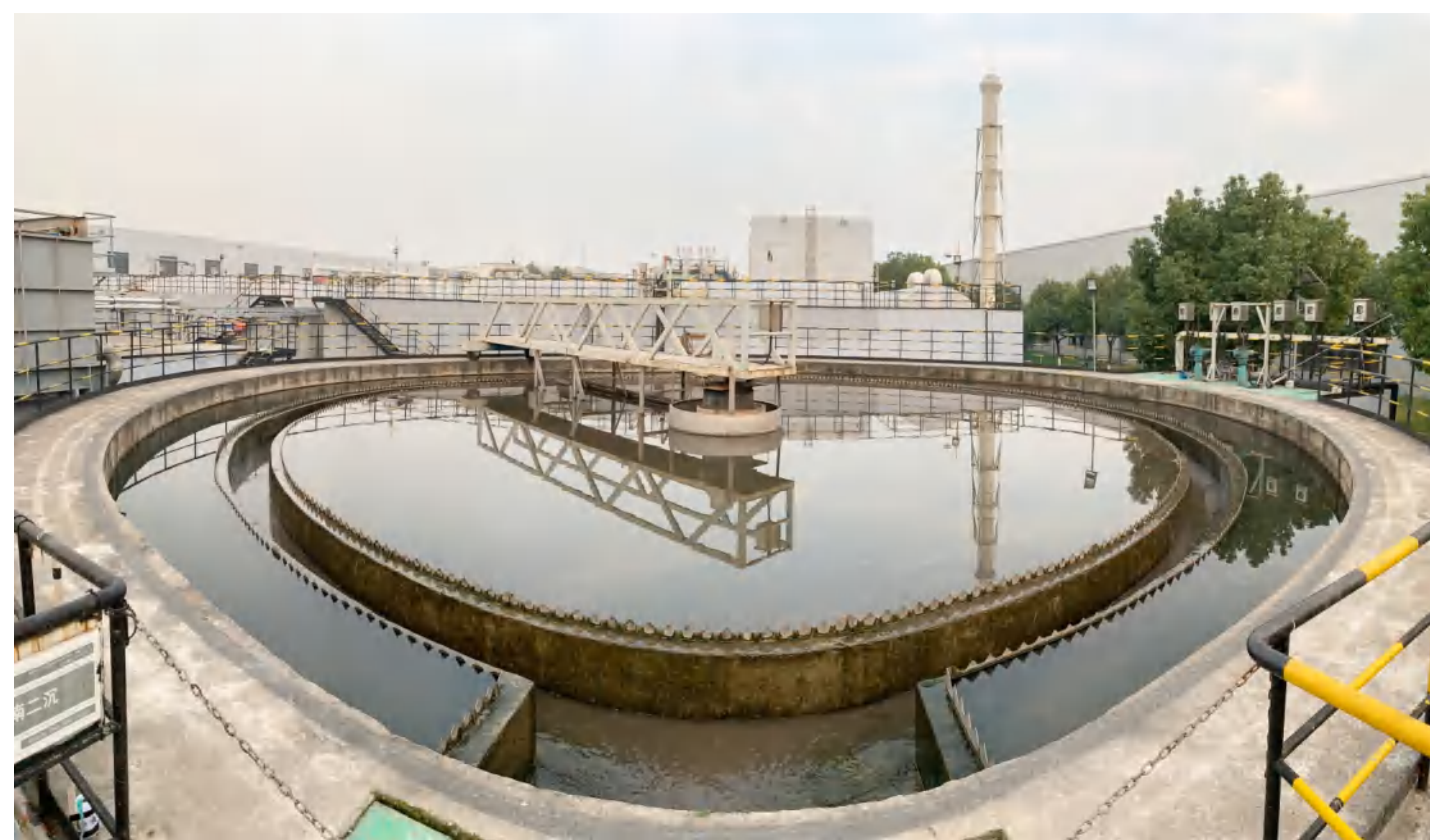
苏州光伏污水站俯瞰图
