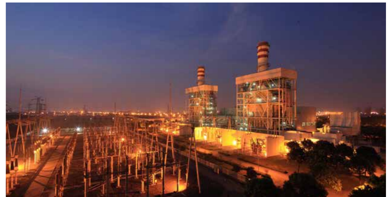
苏州蓝天燃气热电项目
